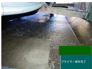
プライマー塗布工
