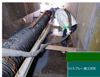
CVスプレー吹付工
