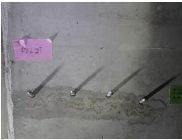
② 削孔・注入プラグ設置
