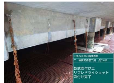
④ 施工完了
