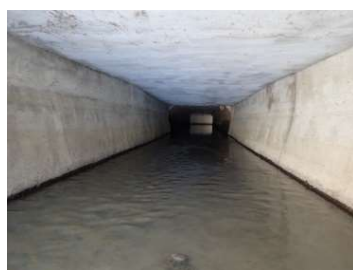
劣化補修対策 断面補修工+表面被覆工
