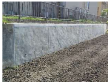
凍害抑制対策 表面被覆工
