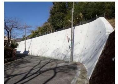
石積風化・転石対策 表面保護工 (FFグリッド併用)
