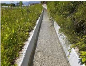
劣化補修対策 表面被覆工
