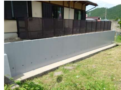
凍害抑制対策 表面被覆工
