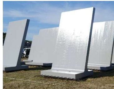
塩害・落書除去対策 表面被覆工
