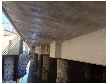
塩害対策 表面被覆工
