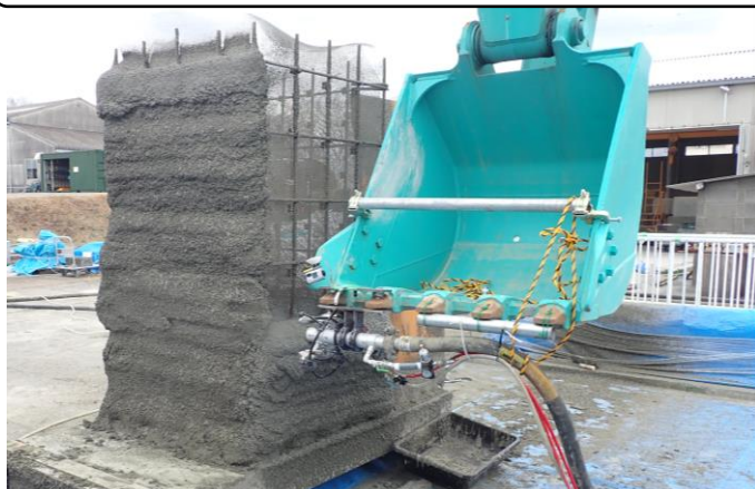
新開発のハイブリッド吹付けシステムを取付けたICT建機による直接プリント造形
