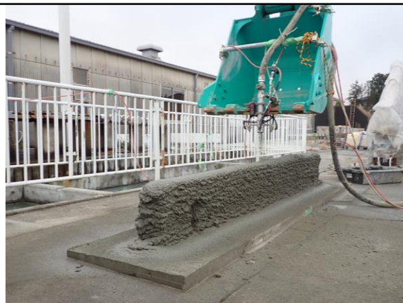
新開発のハイブリッド吹付けシステムを取付けたICT建機による直接プリント造形
